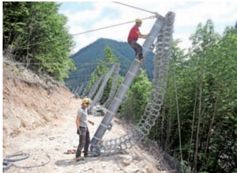
Sanacija brežine nad naseljem Na plavžu poteka po načrtih. / Foto: Gorazd Kavčič
